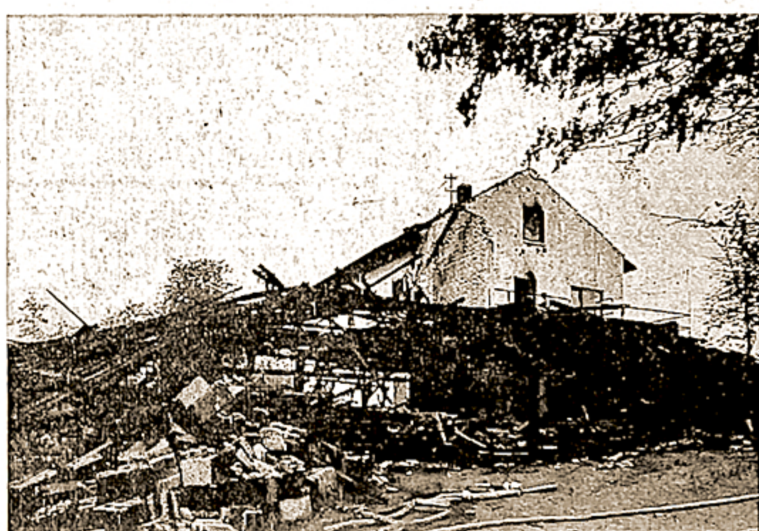
Raub der Flammen. Der Sachschaden wird auf rund 120 000 Mark geschätzt. Die Brandursache ist nicht bekannt. Ex-
